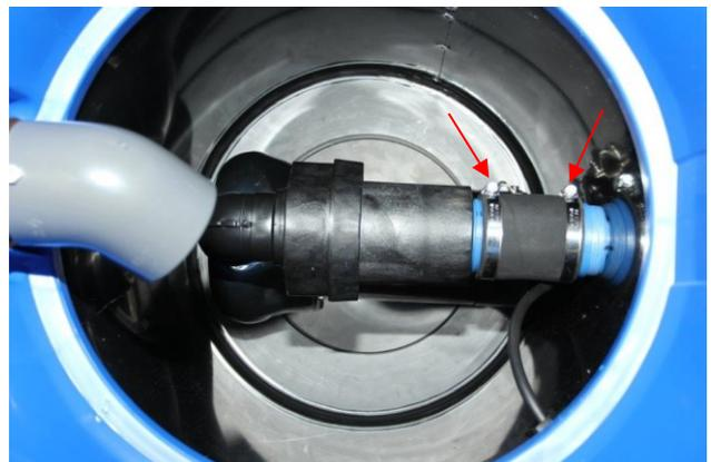
3. Kabledurchführung der Entleerungspumpe aus dem Behälter entnehmen.
